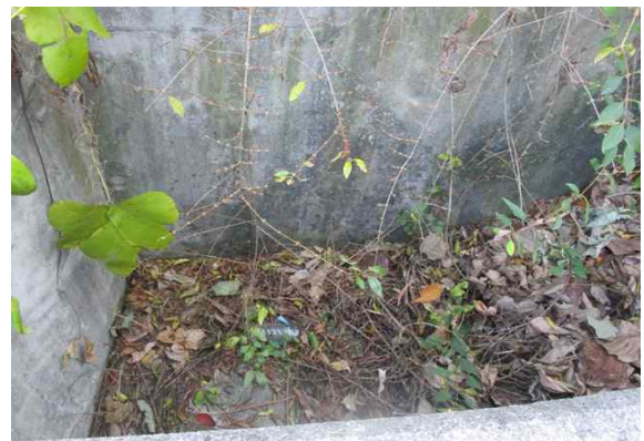
종점부 도수로 전경
