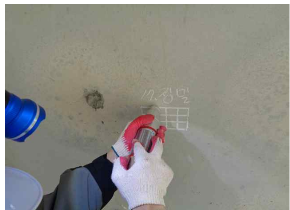
반발경도 측정 현황(측벽부)
