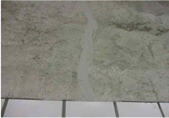
라이닝 SPAN.22 측벽부 균열 보수현황
