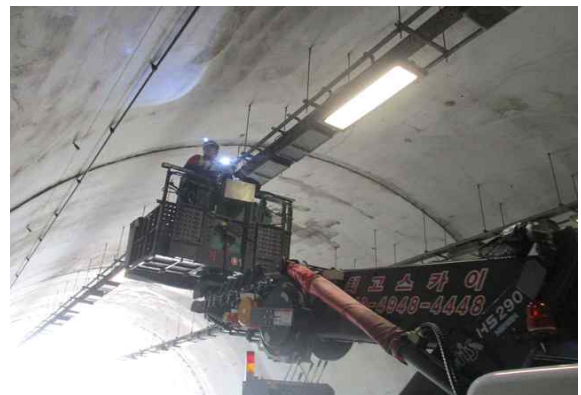
고소작업차를 이용한 외관조사 현황④
