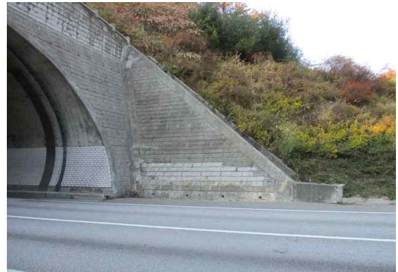
종점부 옹벽 상태양호
