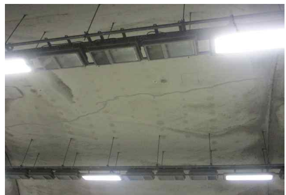
라이닝 SPAN.20 천단부 균열 보수현황
