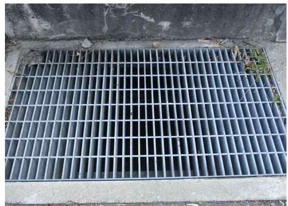
배수시설 집수구 상태양호
