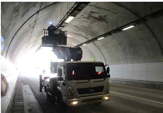
고소작업차를 이용한 외관조사 현황③
