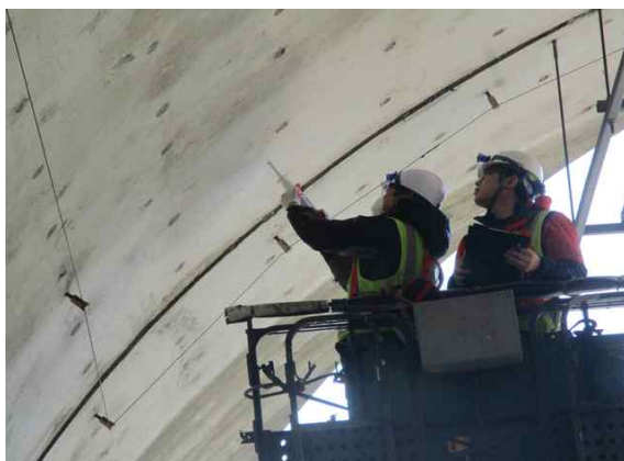
반발경도 측정 현황(천단부)
