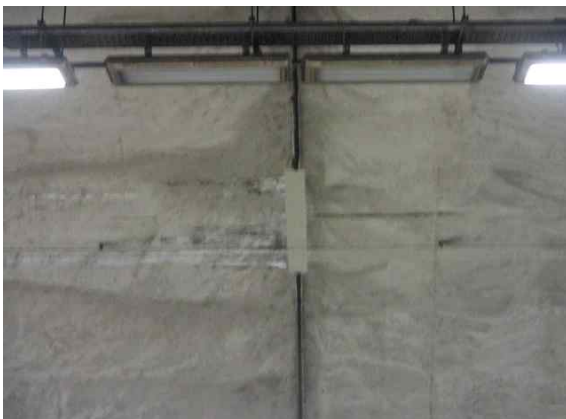
라이닝 SPAN.34 조인트부 채움재 파손 보수
