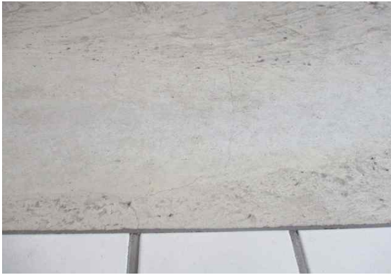
라이닝 SPAN.8 균열(0.3mm미만)
