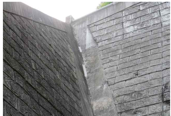
종점부 갯문 균열 보수현황
