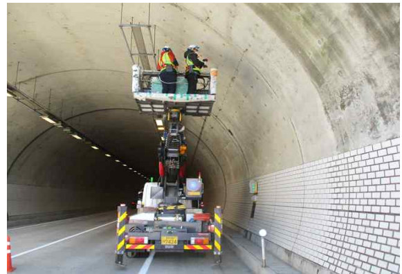
고소작업차를 이용한 외관조사 현황②
