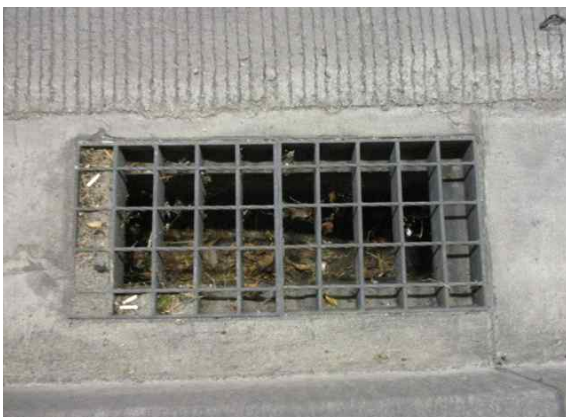
배수시설 집수구 전경
