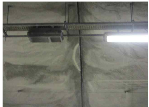
라이닝 SPAN.49 천단부 균열 보수현황
