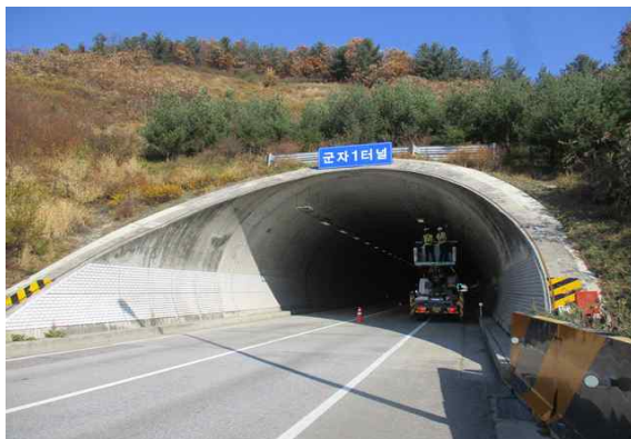
시점부 사면 전경
