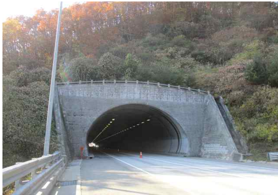
종점부 옹벽 전경
