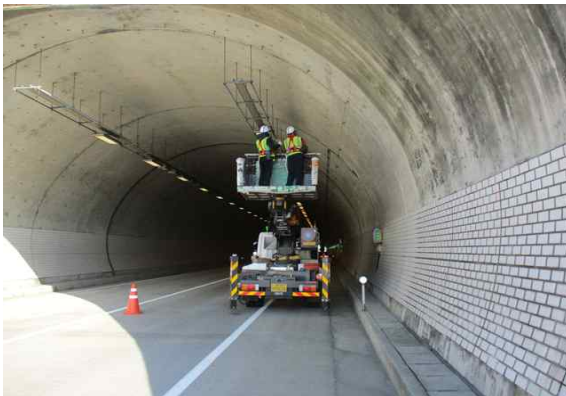
고소작업차를 이용한 외관조사 현황①
